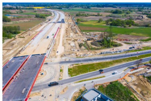
Construction d'une autoroute
