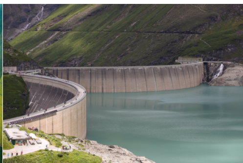
Construction d'un barrage
